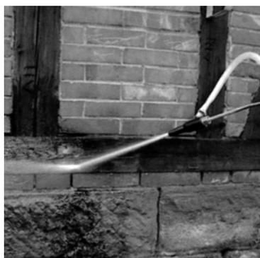
Die Nassstrahleinrichtung lässt sich einfach am Strahlrohr der Kärcher Hochdruckreiniger montieren. Das entsprechende Strahlmittel wird angesaugt, im Wasserstrahl mitgerissen und mit stark abrasiver Wirkung ausgebracht. Ideal zum Entrosten, Entzundern und Entlacken von Bauteilen sowie zur effektiven Entfernung von Graffiti.
